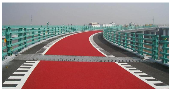
Рис. 1. Пример устройства покрытия дорожной одежды из цветного асфальтобетона
