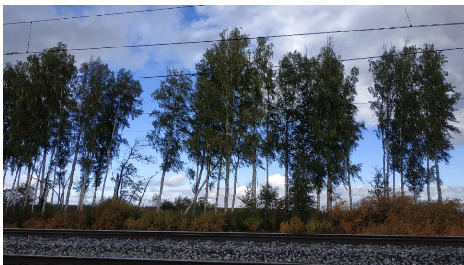
Рис. 2. Разреженная защитная лесополоса (80 км направления Екатеринбург – Каменск-Уральский)
