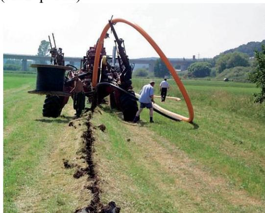
Fig. 3. Trenchless Technology – Plow method (ASB portál).
