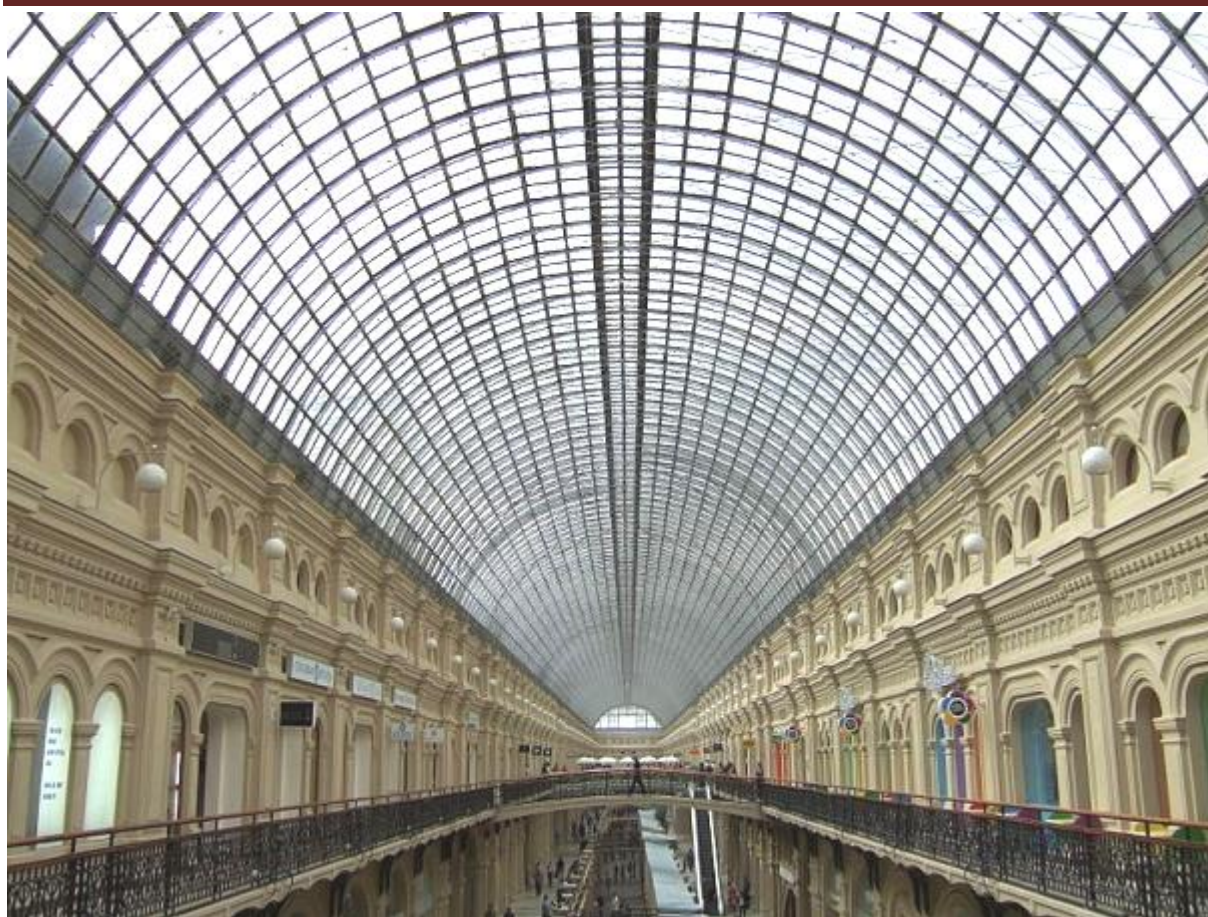
Металло-стеклянные перекрытия ГУМа конструкции В.Г.Шухова, Москва ( http://www.liveinternet.ru/users/astrahanka/post166379496 ).
