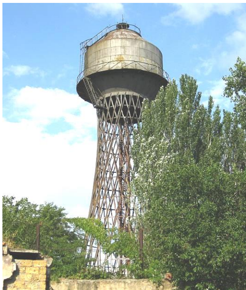
Гиперболоидная башня конструкции В.Г. Шухова в Николаеве (Чумаков, 2012).
