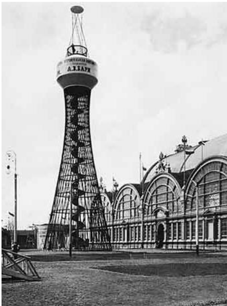
Всероссийская Нижегородская ярмарка. Гипербо- лоидная башня Шухова на фоне главного павильона. Нижний Новгород. 1896 г. Фото М. Дмитриева.
