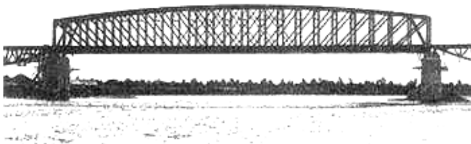
Мост через реку Китай. Транссибирская железная дорога 19 августа 1889 г. Исторический фотоснимок. Архив РАН (Мышко, 2004).
