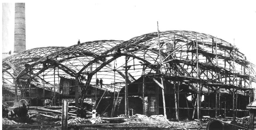
Строительство первых в мире оболочек-перекрытий двойкой кривизны конструкции В.Г. Шухова на Выксунском металлургическом заводе. Выкса, 1897 (Владимир Григорьевич Шухов..., 2013).
