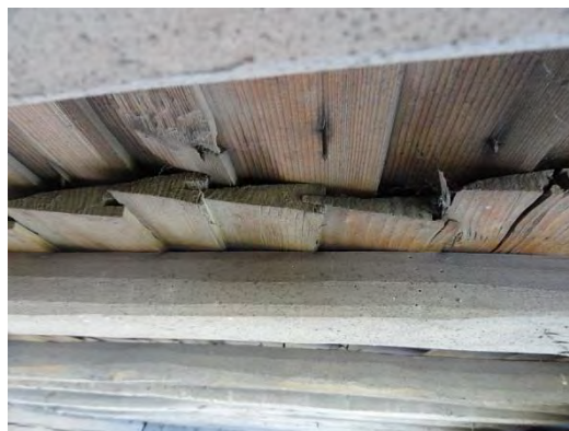
Рис. 2. Установка гонтин в настильном ряду
