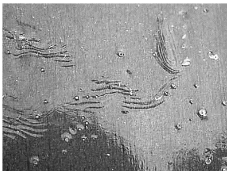
Рис. 1. Пузыри на лакокрасочном покрытии
