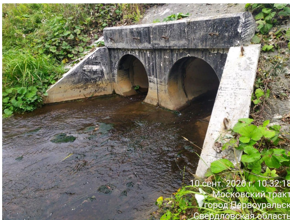
Водопропускная труба на постоянном водотоке р. Чаша в Свердловской области
