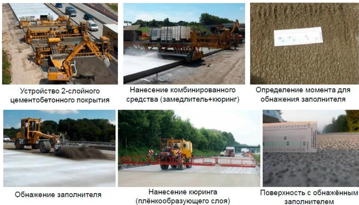
Рис. 1. Последовательность создания цементобетонных покрытий с обнаженным заполнителем
