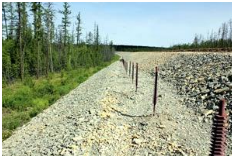
Рис. 3. Пример применения термосвай вдоль земляного полотна в условиях вечномёрзлых грунтов
