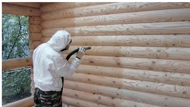
Рис. 9.4. Пескоструйная обработка оцилиндрованного бревна
