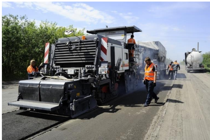
Рис. 3. Ремонт автомобильных дорог методом холодной регенерации
