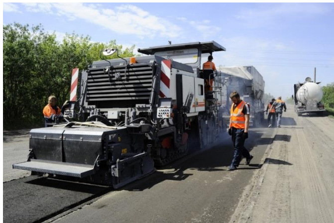
Рис. 3. Ремонт автомобильных дорог методом холодной регенерации
