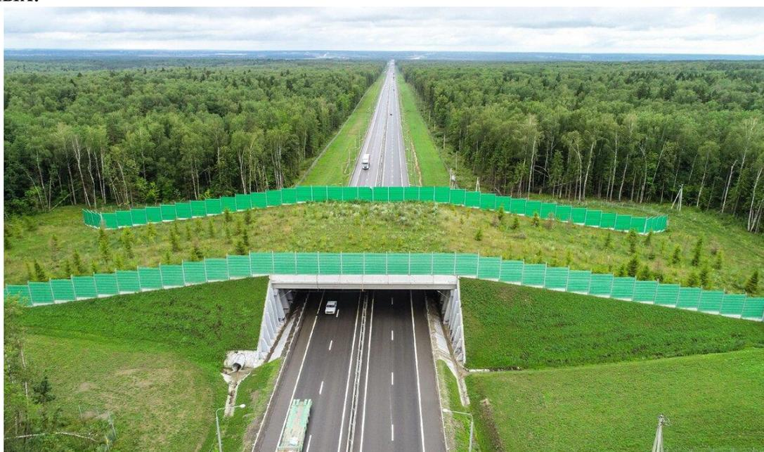
Рис. 1. Ландшафтный мост (экодук) для пересечения дороги дикими животными
