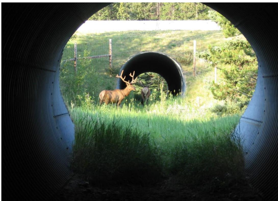
Рис. 2. Экодуки тоннельного типа для пересечения дороги дикими животными
