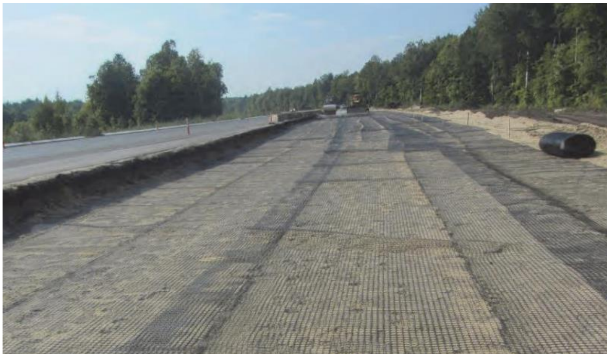
Армирование нижнего слоя дорожной одежды георешеткой полимерной дорожной марки «Славрос СД»
