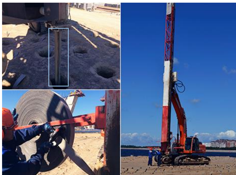
Рис. 4. Применение ленточных геодрен
