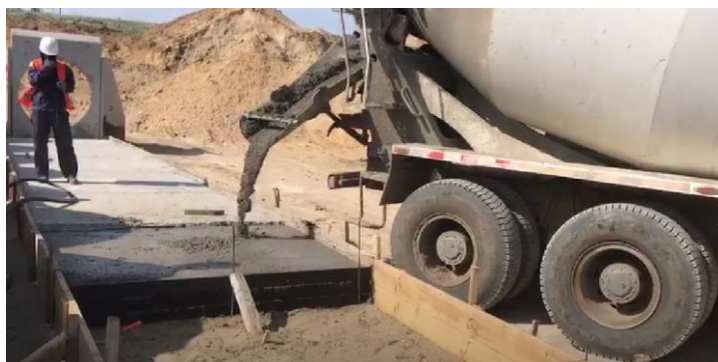
Рис. 3. Заливка опалубки
