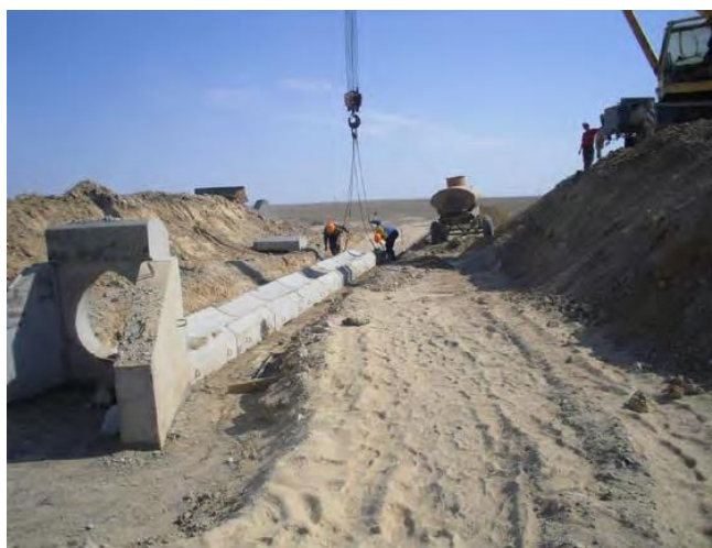
Рис. 2. Установка лекальных блоков
