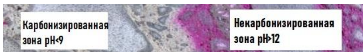
Рис. 2. Качественный анализ бетона на карбонизацию (индикатор–фенолфталеин)
