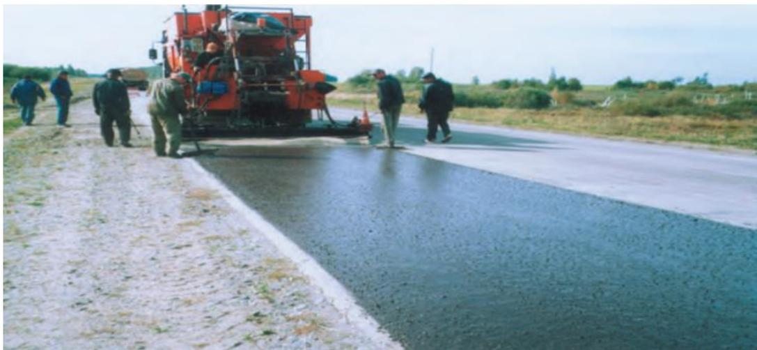
Рис. 2. Устройство защитного слоя «Сларри-Сил»
