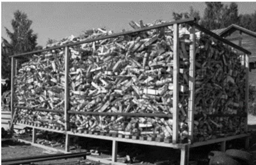
Рис. 1.4. Хранение дров в контейнере с основанием, изолированным от грунта, и вентилируемыми стенками
