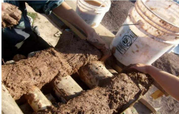
Рис. 2. Ленточный способ укладки раствора
