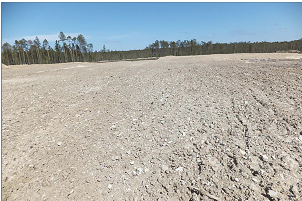
Рис. 2. Чистовая планировка нарушенной поверхности участка земли Fig. 2. The final layout of the disturbed surface of the land plot
