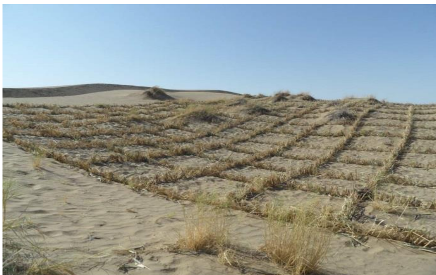
Рис. 2. Закрепление барханных песков клеточными защитами
