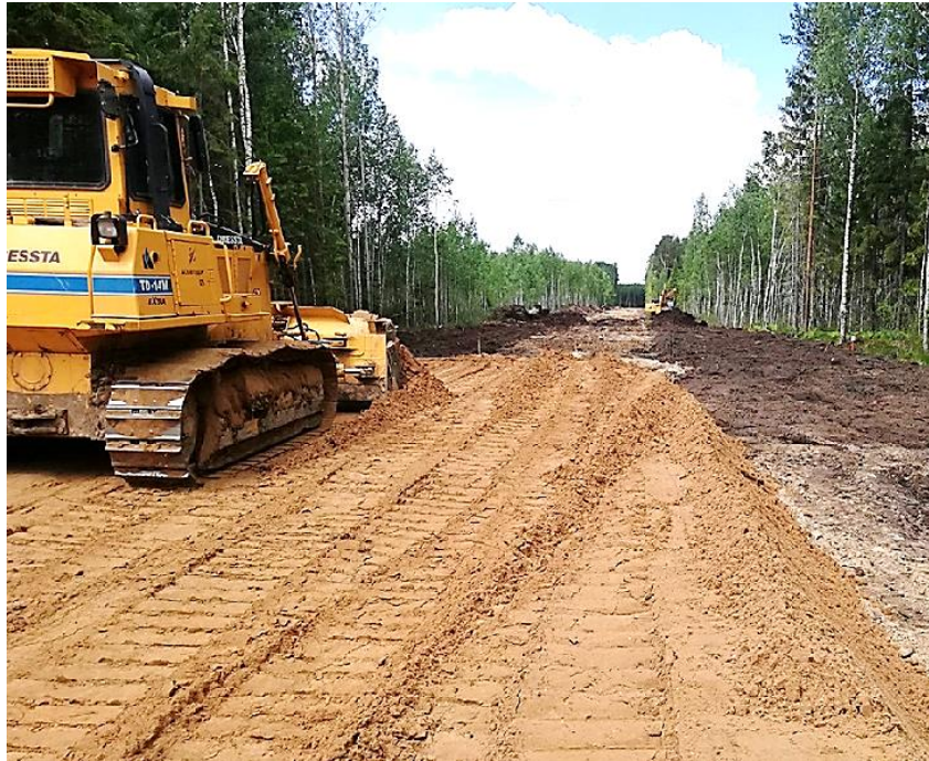
Рис. 3. Распределение подготовленного к укреплению грунта
