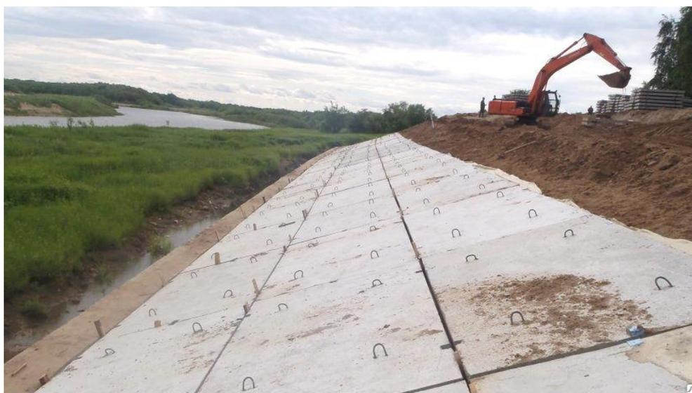
Рис. 5. Установка плит
