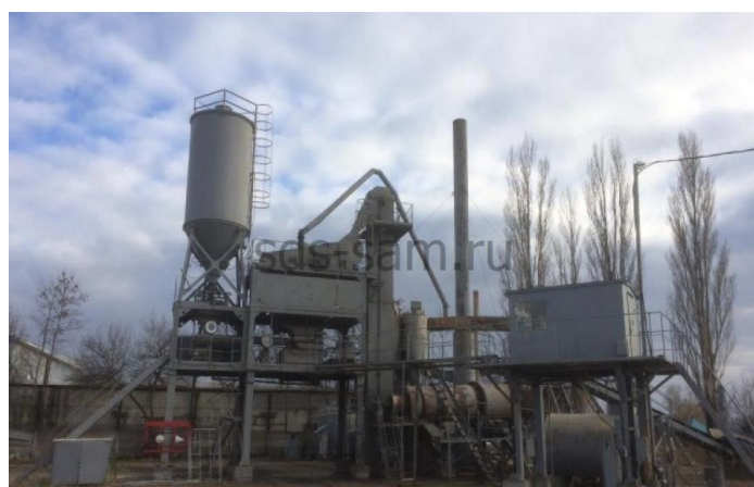
Рис. 2. Устаревшая асфальто-смесительная установка ДС-158, требующая модернизации
