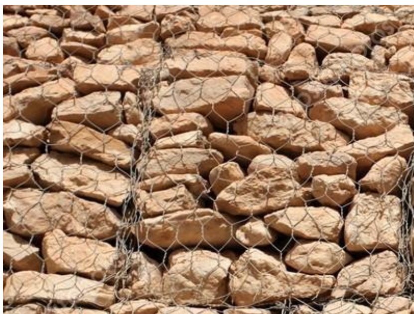
Рис. 1. Габионы коробчатой конструкции
