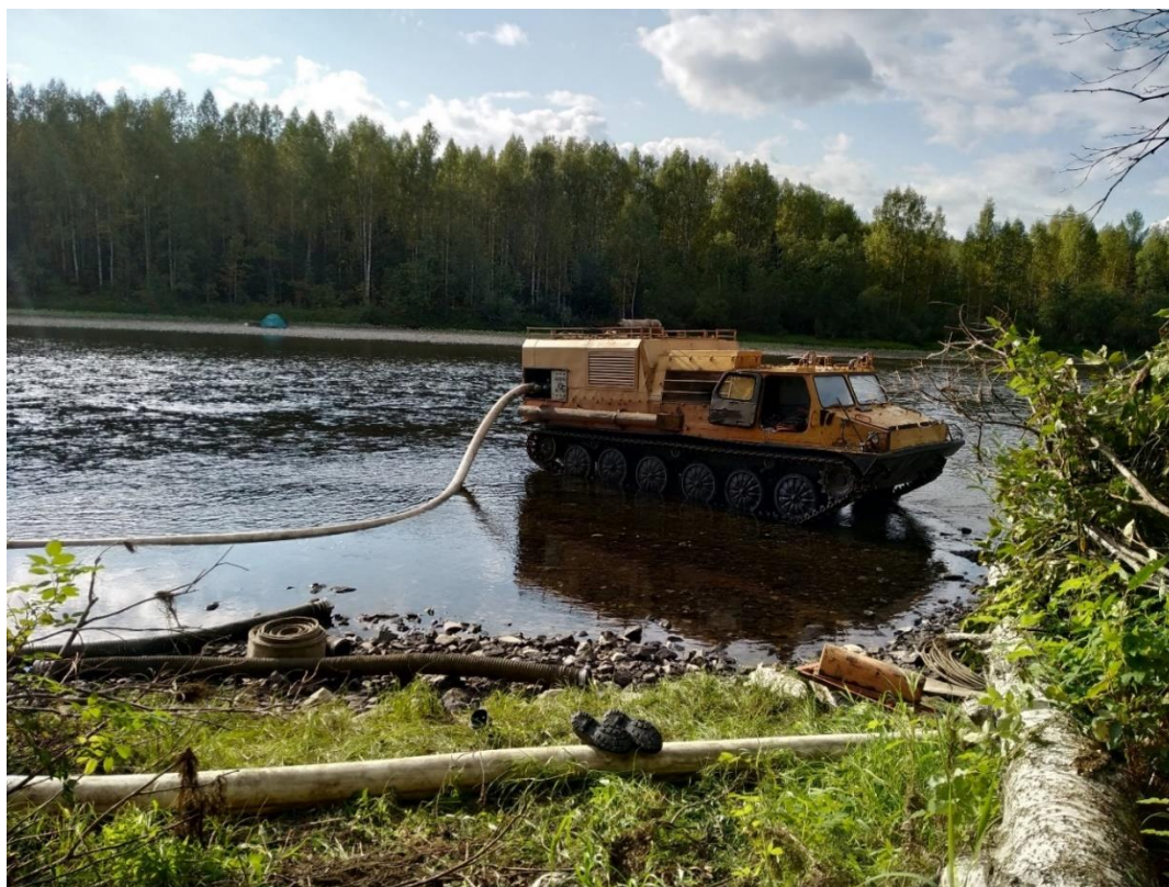
Рис. 23. Насосная станция на базе ГТ-ТМС
