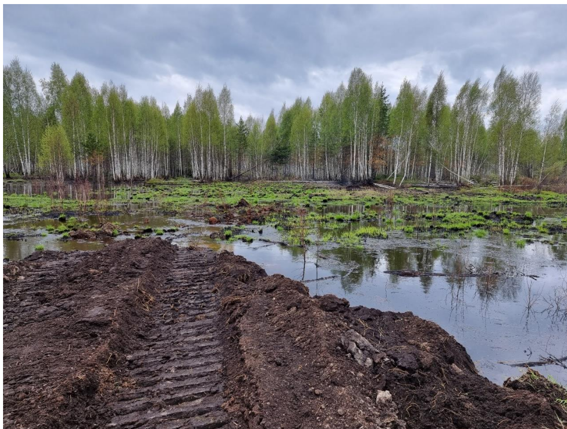
Рис. 22. Гребень плотины и образовавшийся перелив
