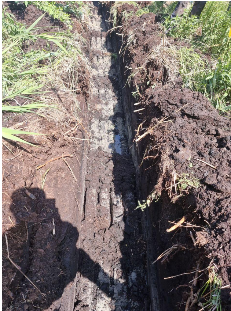
Рис. 14. Канавы, прокопанные до минерализованного горизонта вокруг очагов тления
