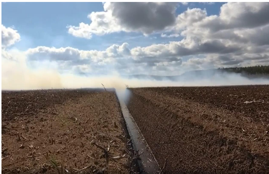
Рис. 15. Обводненная канава, созданная с целью тушения торфяного пожара
