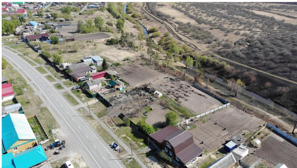
Рис. 1. Последствия перехода лесного пожара в село Салаирка, 2023 г.
