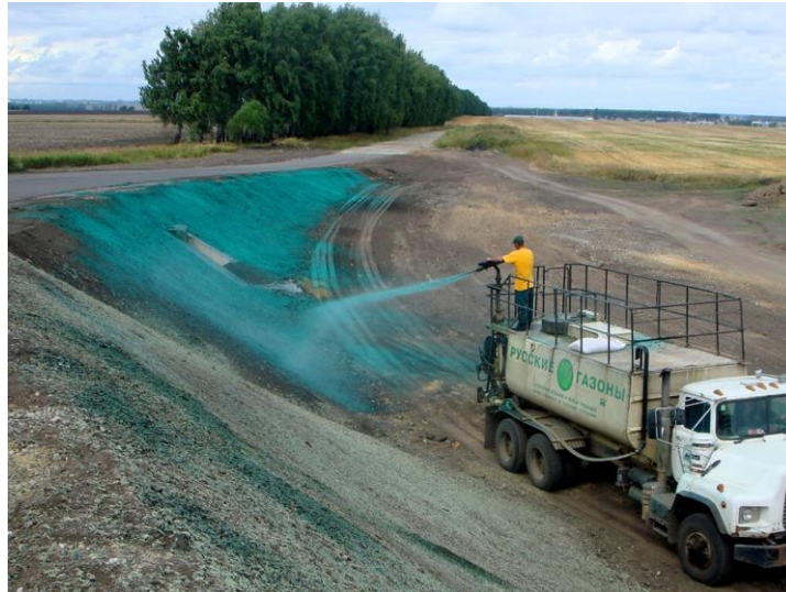
Рис. 3. Нанесение смеси с помощью гидросеялки ДЭ-16
