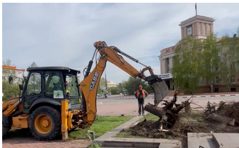
Рис. 2.10. Корчевка пней при помощи экскаватора
