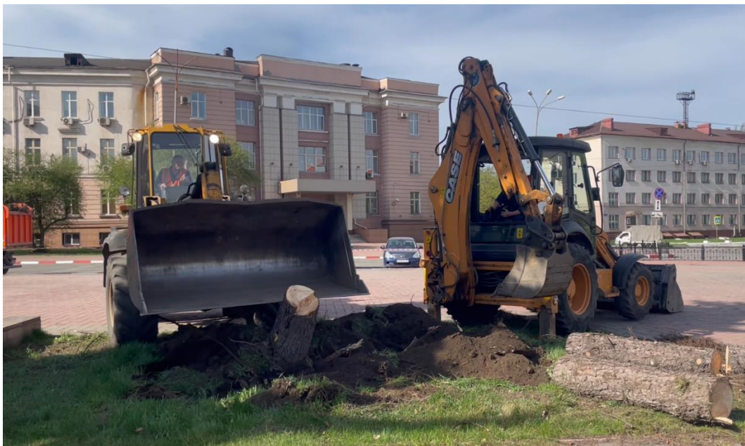
Рис. 2.11. Корчевка пней при помощи бульдозера и экскаватора
