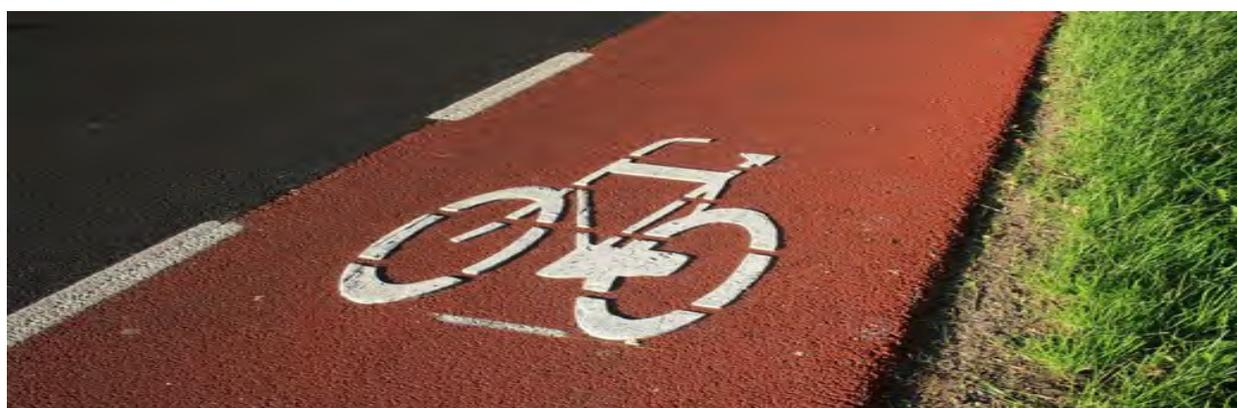
Рис. 4. Велосипедная дорожка из цветного асфальтобетона
