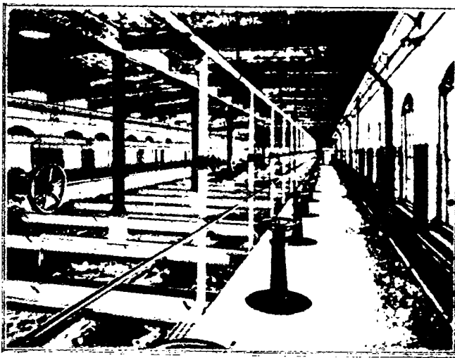
Фильтровальная станция. Двадцать песочных фильтров с общей производительностью 75.000 куб. метров.
