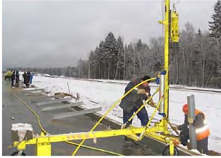
Рис. 311. Сваебойная установка
