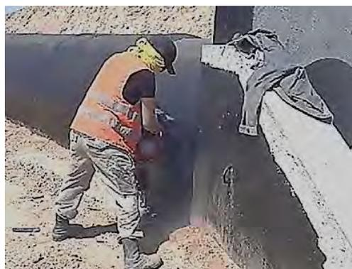
Рис. 121. Использование вибротрамбовок при обратной засыпке водопропускных сооружений
