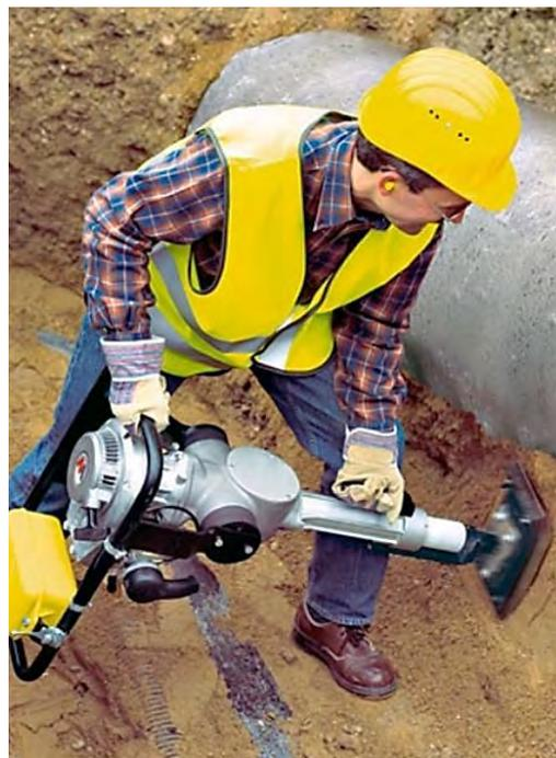
Рис. 119. Использование бензиновой вибротрамбовки при обратной засыпке водопропускных сооружений
