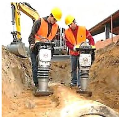
Рис. 120. Использование электрических вибротрамбовок при обратной засыпке водопропускных сооружений
