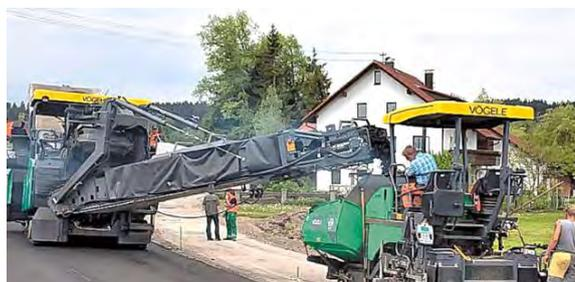
Рис. 175. Асфальтоукладчик с перегружателем
