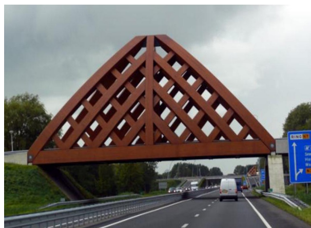
Рис. 4. Мост, изготовленный из клееного соснового ацелированного бруса (Нидерланды) Fig. 4. Bridge made of glued pine acetylated square log (the Netherlands)
