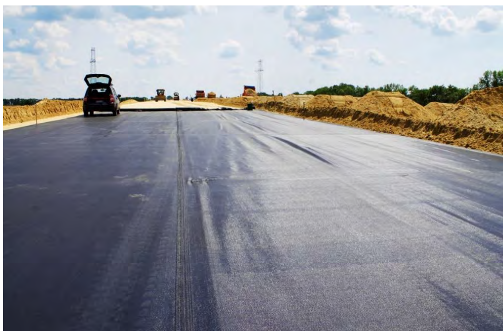
Рис. 1. Геотекстиль, уложенный на земляном полотне
