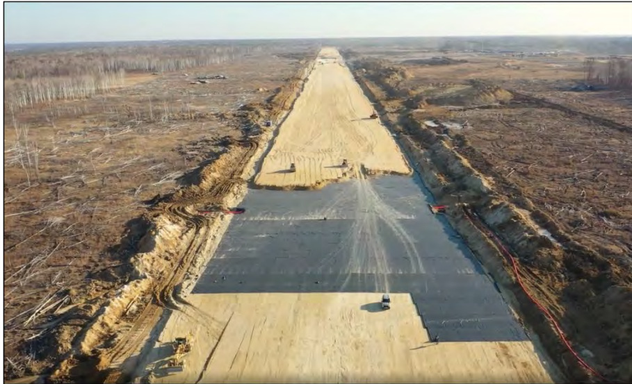
Рис. 3. Армирование основания взлетно-посадочной полосы при строительстве аэропортового комплекса космодрома «Восточный»
