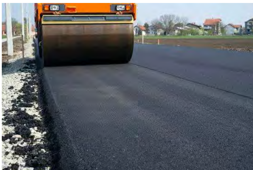
Укладка асфальтобетона на толщину более 8 см
