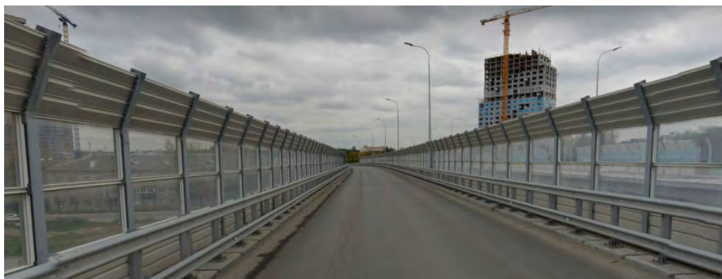
Рис. 1. Шумозащитные экраны, установленные на транспортной развязке в Екатеринбурге
