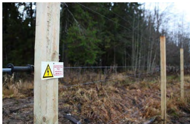
Рис. 2. Ограждение «Электронный пастух». Вологодская область, федеральная дорога Вологда–Новая Ладога (км 42 – км 47)
