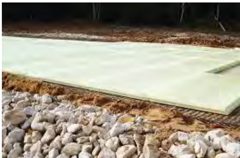
Монтаж пенополистирольных плит
