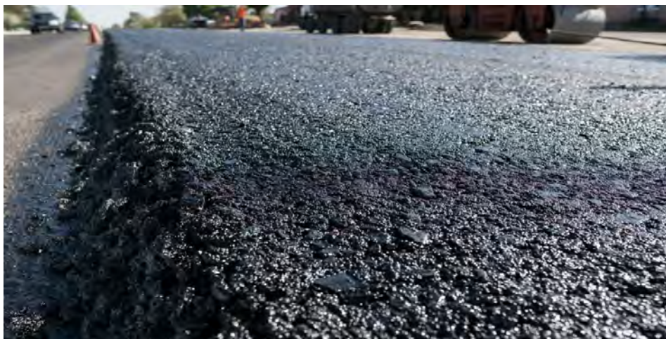
Рис. 3. Асфальтобетонное покрытие с адгезионной добавкой
