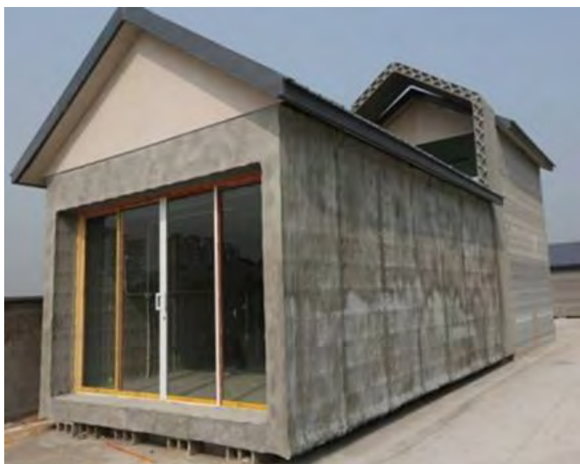
Рис. 1.7. Дом, построенный с помощью 3D-принтера 7
