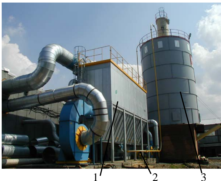
Рис. 36. Централизованная цеховая обеспыливающая установка:
