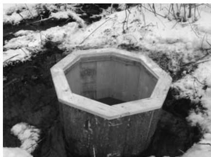
Рис. 2. Каптаж истока родника после мероприятий по благоустройству
