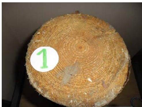
Рис. 7. Образец № 1 – торцевые трещины
