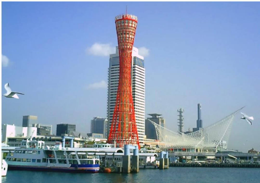
Гиперболоидная башня порта Кобе выдержала землетрясение в 7 баллов по шкале Рихтера. Япония, 2005 (Владимир Григорьевич Шухов..., 2013).
