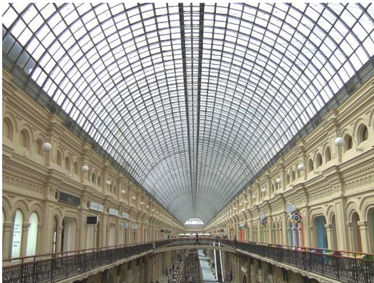
Металло-стеклянные перекрытия ГУМа конструкции В.Г.Шухова, Москва ( http://www.liveinternet.ru/users/astrahanka/post166379496 ).
