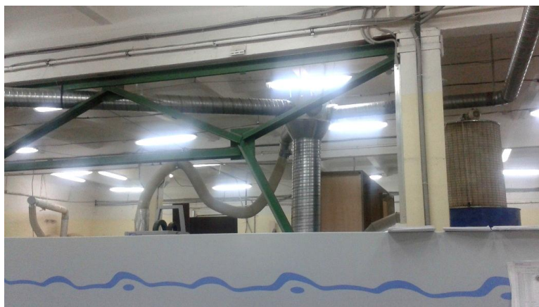
Рис. 7. Общий вид подключения станков к системе K2 через коллектор с отводами
