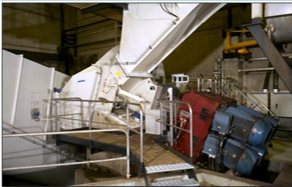
■ HQ-Chipper™, Metsä-Botnia Ab, Kaskinen, Finland
