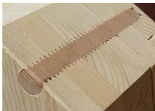
Рис.3. Разрез панели NUR-HOLZ
