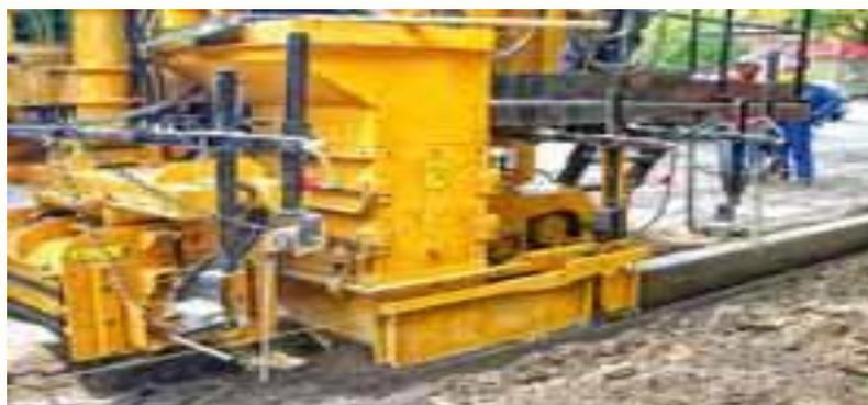
Рис. 2. Устройство барьера с помощью Curb Appeal CLS600
