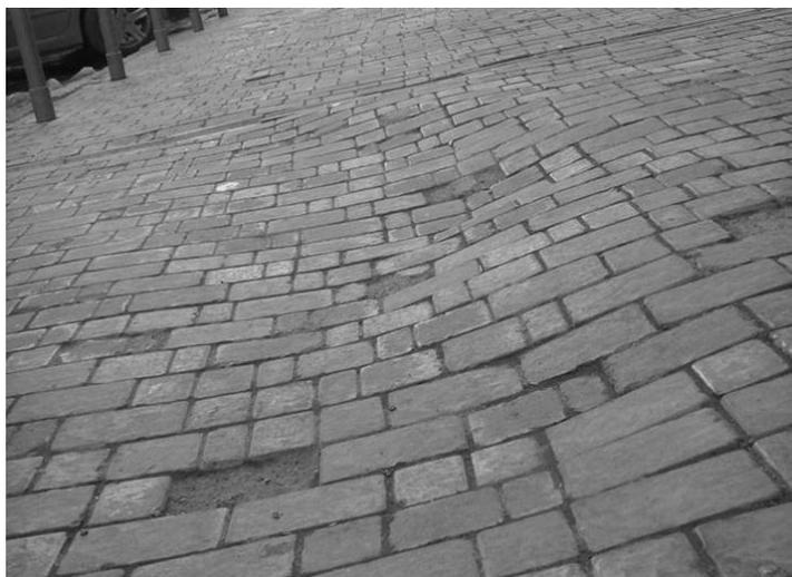
Последствия некачественной укладки тротуарной плитки
