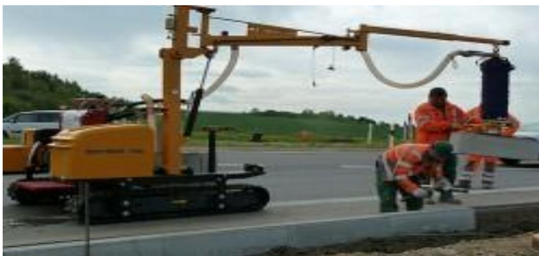
Рис. 1. Укладка дорожного бетонного изделия
