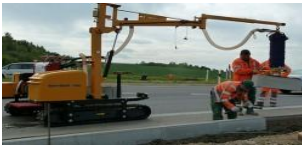
Рис. 1. Укладка дорожного бетонного изделия
