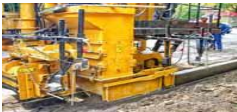
Рис. 2. Устройство барьера с помощью Curb Appeal CLS600
