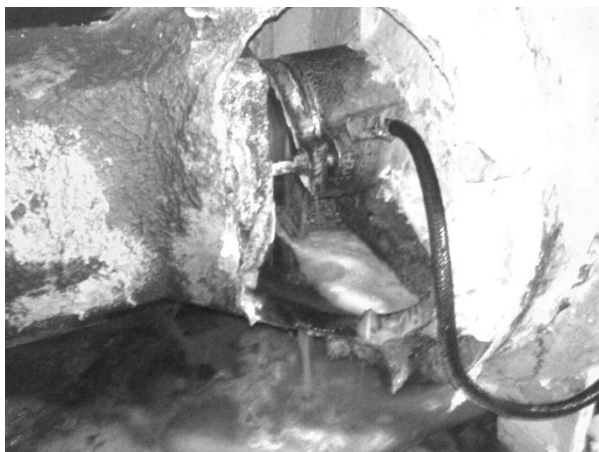
Рис. 1. Течь сальниковых уплотнителей
