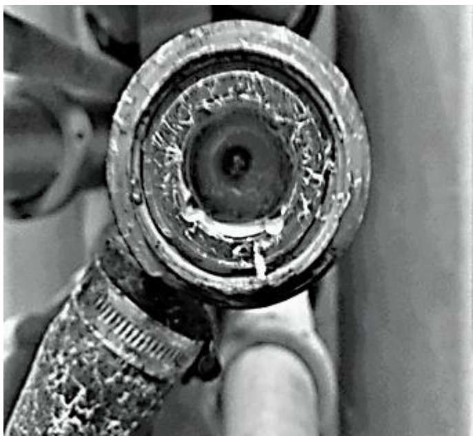
Рис. 2. Формирование следа от вакуумного столба при нормальной работе вихревого очистителя
